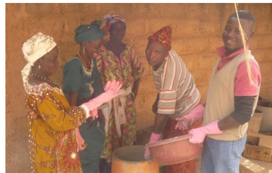
Abb. 7: Bei einem Workshop werden Frauen im Auftragen der Zementschicht geschult.
