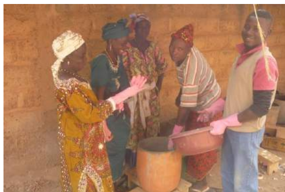
Fig. 8 : Des femmes apprennent d'appliquer la couche de ciment pendant une formation.
