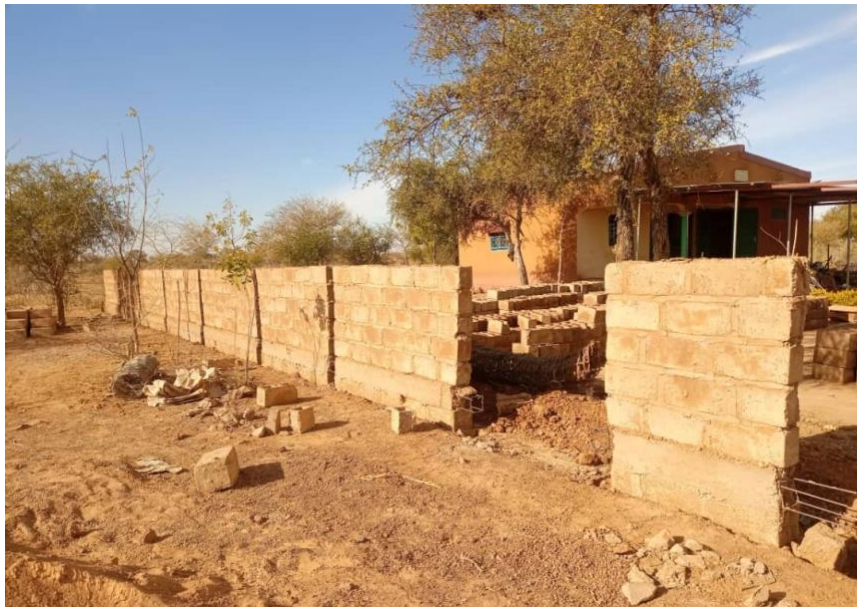
Abbildung 4: Fast fertige Mauer
