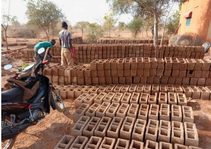
Abbildung 3: Die Steine werden vor Ort aus Beton hergestellt
